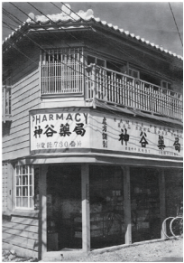
旧神谷薬局 (左) とリノベーション後の外観。2022年、第8回 沖縄建築賞奨励賞を受賞
