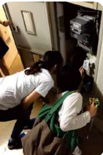
ガス安全装置の復旧作業
