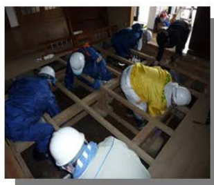
床をはがしての泥出し作業には大工経験などがあるとよい
