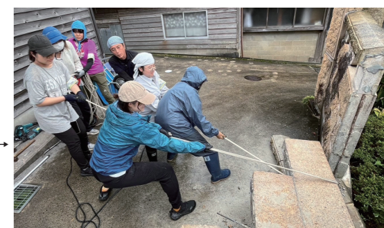
能登半島地震の被災地で倒壊した塀を撤去→
